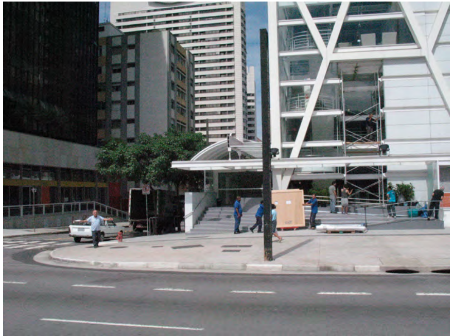
Montagem da obra.
